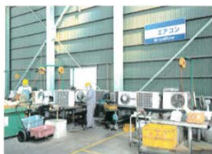
②解体作業の様子。
