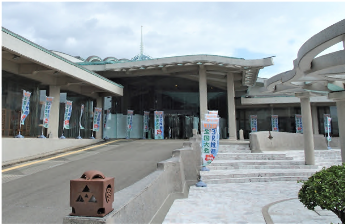
会場となった沖縄コンベンションセンターの会議棟A
