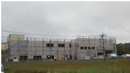
建設中の関エコフィードセンター
