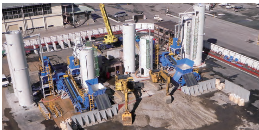
図3 土工資材設備全景
