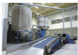
発泡スチロール破砕減容施設
