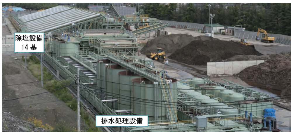
図2 除塩施設全景
