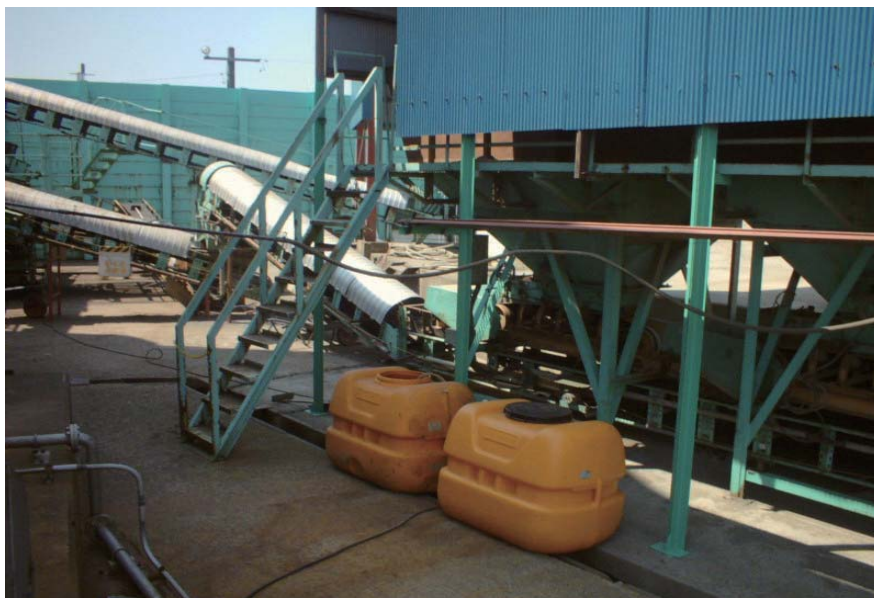
雨水の備蓄タンク
