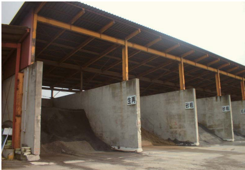
再生骨材等使用資材のストックヤード
