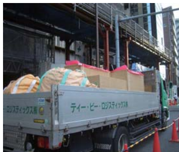
①建設現場に製品到着
