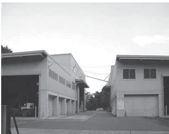
中山工場（木質燃料製造施設）
