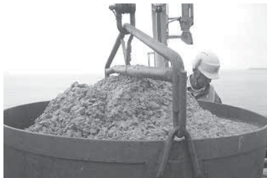
シェルコンクリートの打設
