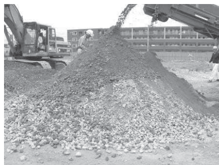
②解体コンクリート塊を細かく破碎し、不純物を取り除いて、再生材として利用できるようにしています。
