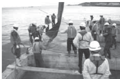
シェルコンクリートの打設
