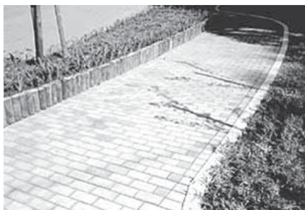
溶融スラグ、フライアッシュ、 廃ガラスを原料にした舗装ブロック
