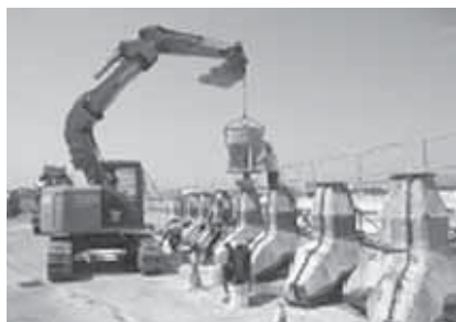
シェルコンクリートの打設
