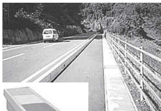
溶融スラグ、廃 ガラスを原料に した側溝蓋と施 工例
