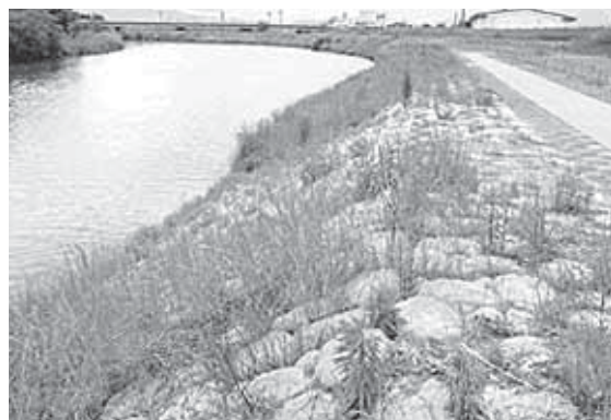
廃ガラスを原料にした環境保全型積みブロック（左）と法面保護ブロック（右）
