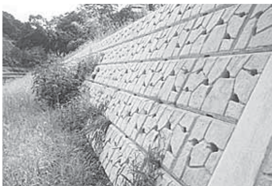
廃ガラスを原料にした環境保全型積みブロック（左）と法面保護ブロック（右）
