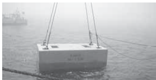
ケーソン根固ブロック
