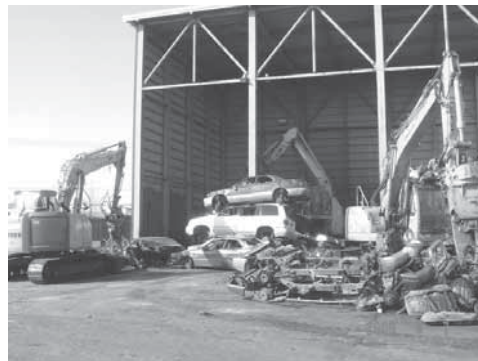
【マルチ解体機作業状況】
