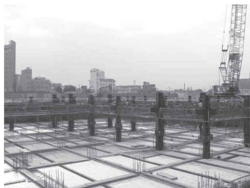
ピットスラブ型枠兼用断熱材
