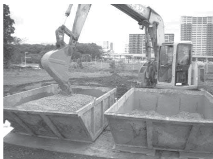
狭小な敷地では、油圧ショベルで攪拌、打設する施工方法も可能です。
