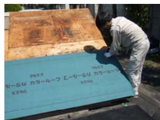
③施工状況
