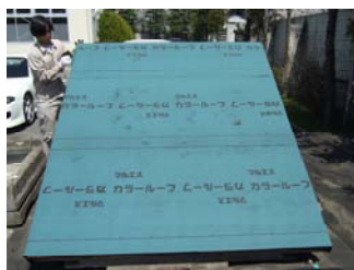
④施工終了(暴露試験継続中)
