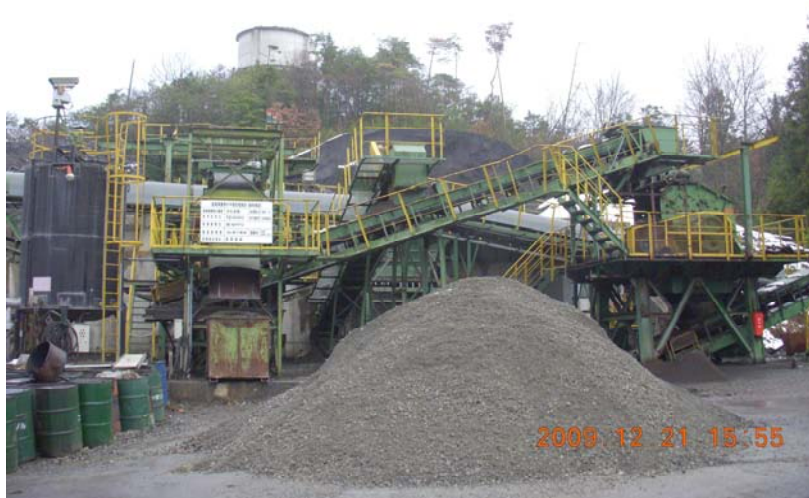
再生製品製造設備の一例
