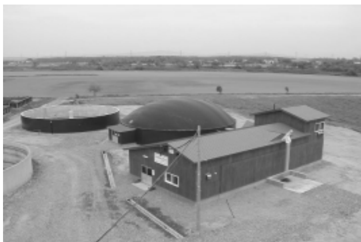
バイオガスプラント全景
