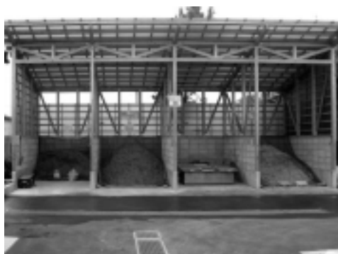
生ごみ堆肥化施設
