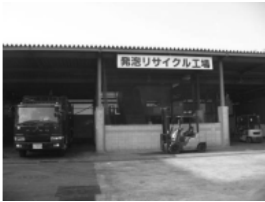
発泡スチロールリサイクル工場
