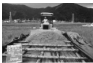
軽量気泡コンクリート廃材による軽量盛土
