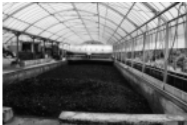
醗酵槽と自走攪拌機
