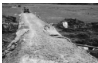
軽量気泡コンクリート廃材による軽量盛土
