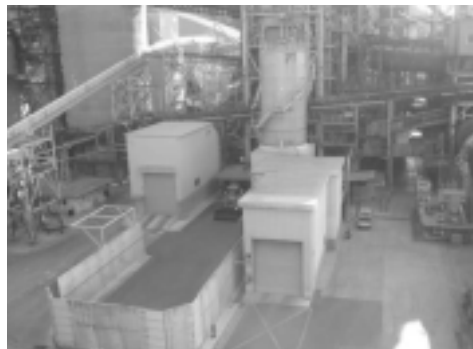
[写真 3:下水道汚泥受入施設]
